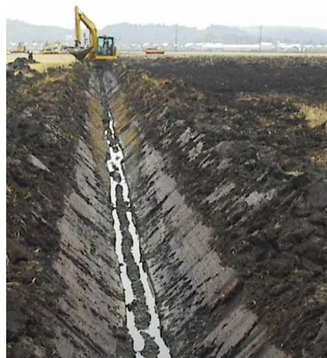
丁張り施工よりもレーザーレベルによる施工のため始点から高精度な掘削が可能です。
