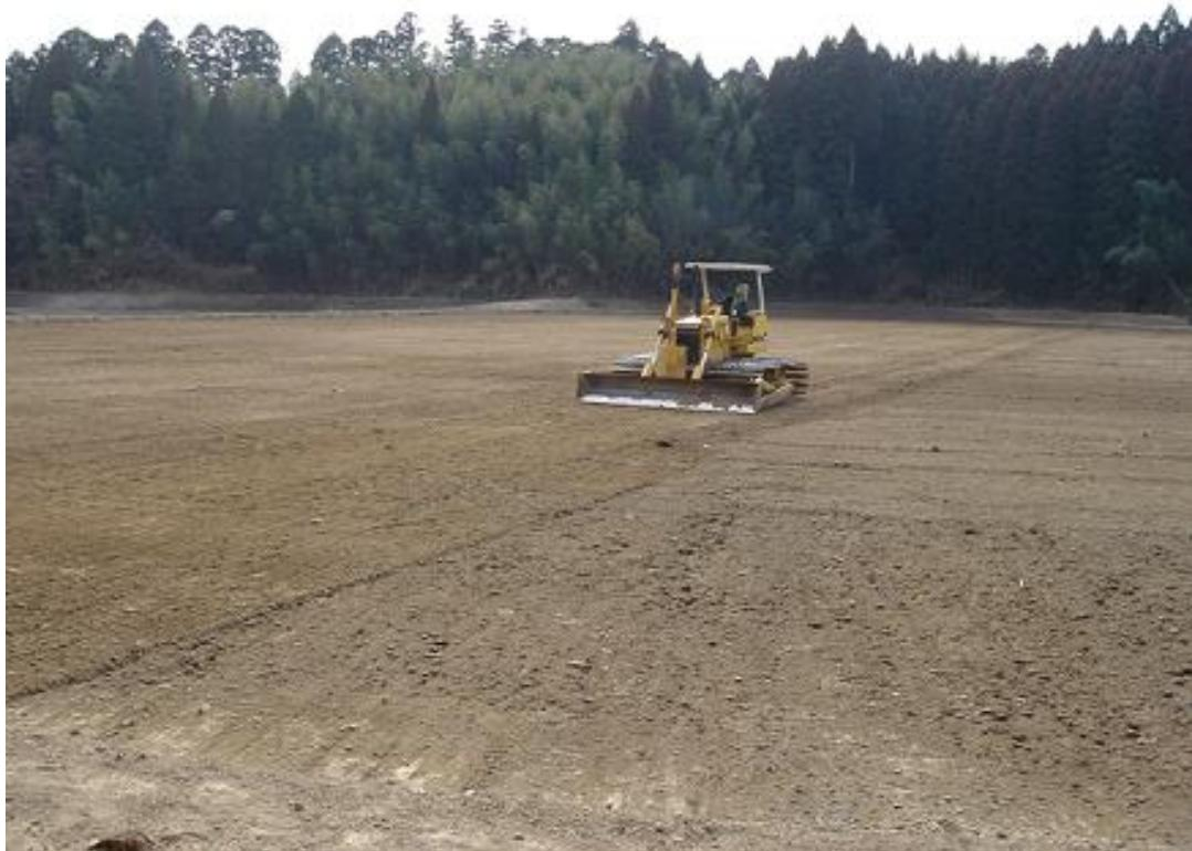
レーザーレベルと併用して使用する。
